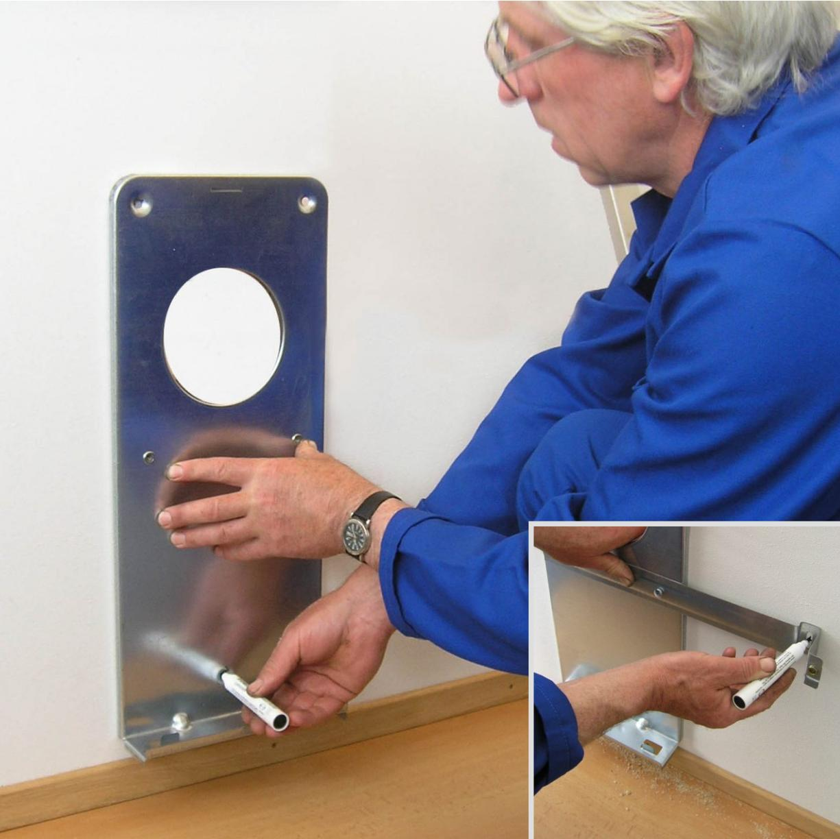
Подвесной лист (БЕТА 2) и подвесной комплект (БЕТА 3,4,5 с подвесной планкой) срисовать на стену и обозначить отверстия для привинчивания и для системы отвода.
