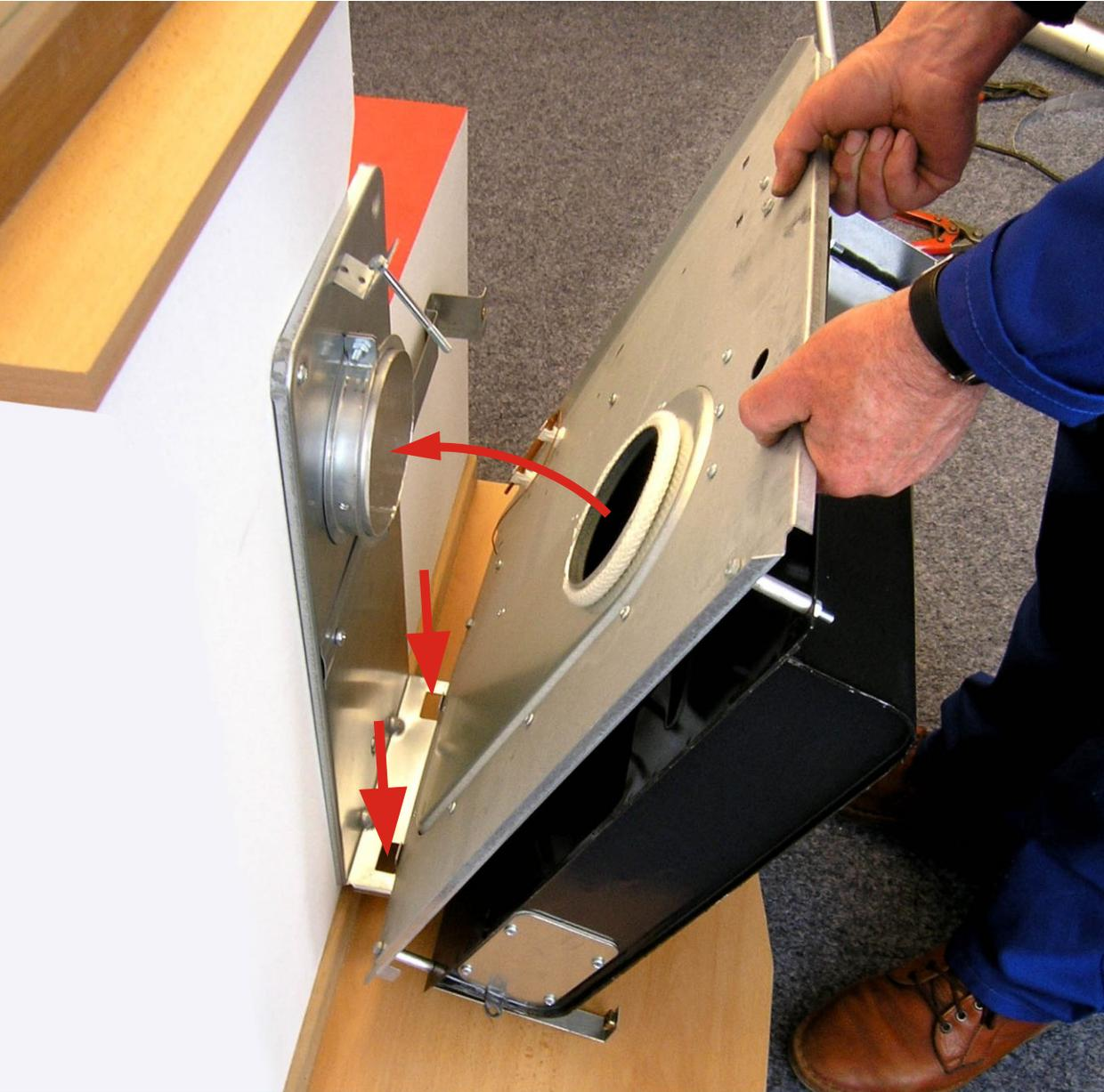
Комплектный отопительный прибор (без крышки) вставить нижней частью в подвесной лист.
