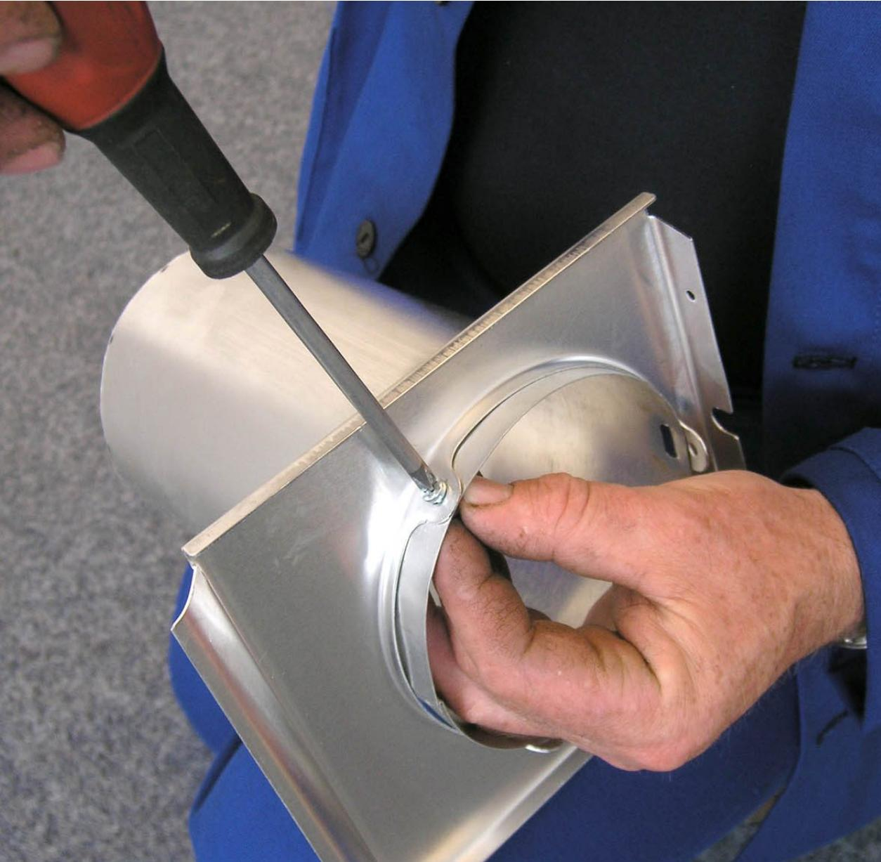
На отверстия во всасывающей трубе прикрепить фланцевую корзину выхода.
